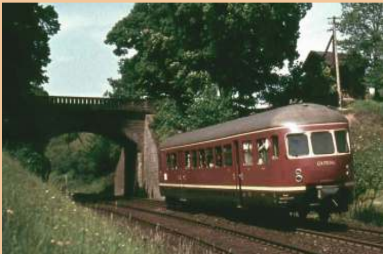
Die Unterführung Hetjershäuser Weg in den fünfziger Jahren Foto Detlev Luckmann
