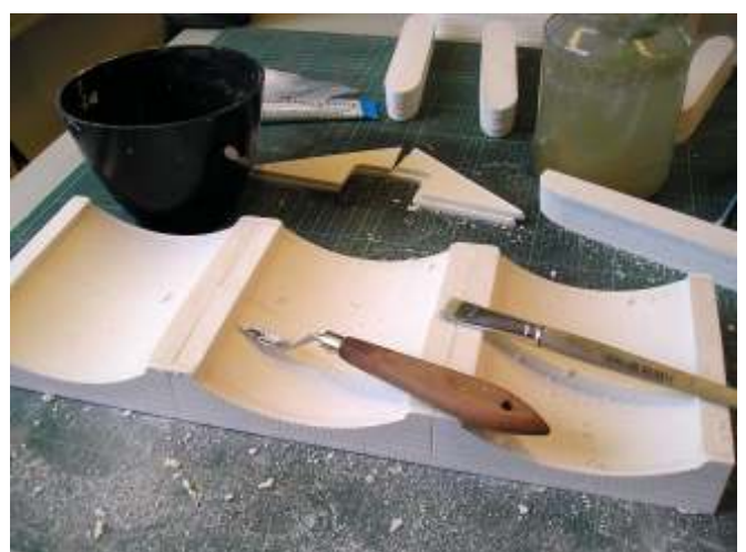
Auch hier werden alle Fugen verspachtelt.
