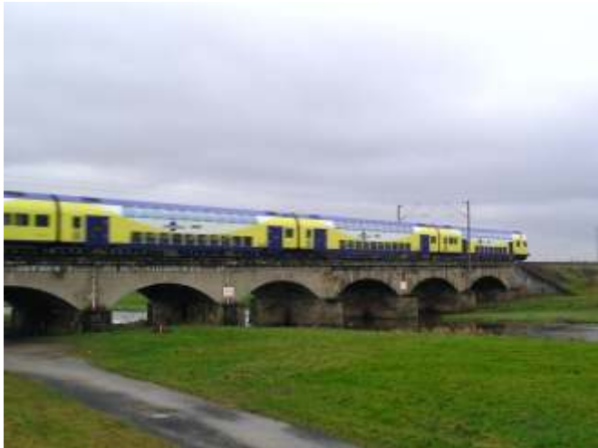
Die Originalbrücke hat sechs Segmentbögen. Unser Demonstrationsmodell wurde mit nur drei Bögen ausgeführt.
