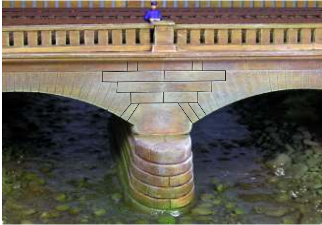
Die Nahtstellen der Steinbauteile müssen verzahnt werden. Dazu wird bei jeweils einer Schicht die Fuge glatt verspachtelt (am besten den Gips mit den Finger verreiben) bzw. bei der nächsten Schicht die Stoßfuge z. Bsp. mit einem Zahnstocher freigekratzt.
