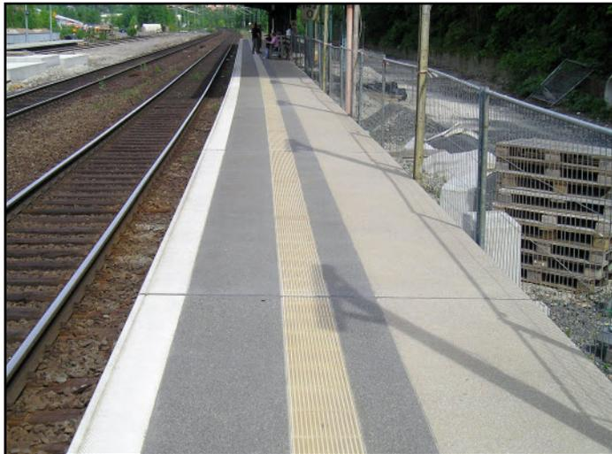
7,50m lange 55cm-Fertigteile in der Kurve verlegt im Bahnhof Münden
