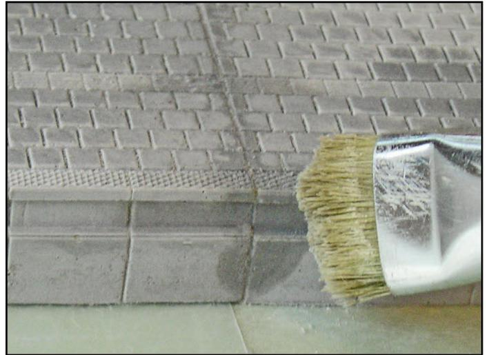
Mit einem Borstenpinsel wird der noch nicht abgebundene Gips abgebürstet, in den Fugen bleibt der Gips stehen.
