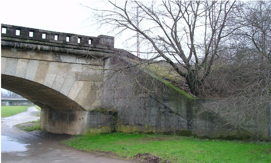
Der südliche Brückenkopf mit Flügelwand heute.
