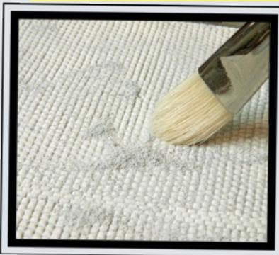
Dazu wird das mitgelieferte Gipspulver einfach mit dem Borstenpinsel in die Stoßfugen eingefegt und dann durch Anfeuchten mit Wasser aus einer Zerstäuber fixiert. Es kann auch Gipspulver auf leicht feuchten Bauteilen regelrecht eingerieben werden.
