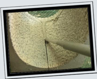
Dazu wird der Gips ungefähr in der Konsistenz von ungeschlagener Sahne angerührt und mit einer Einwegpipette oder einem Modellspachtel auf die Fugen gegeben. Der dünnflüssige Gips läuft nun in den Spalt.
